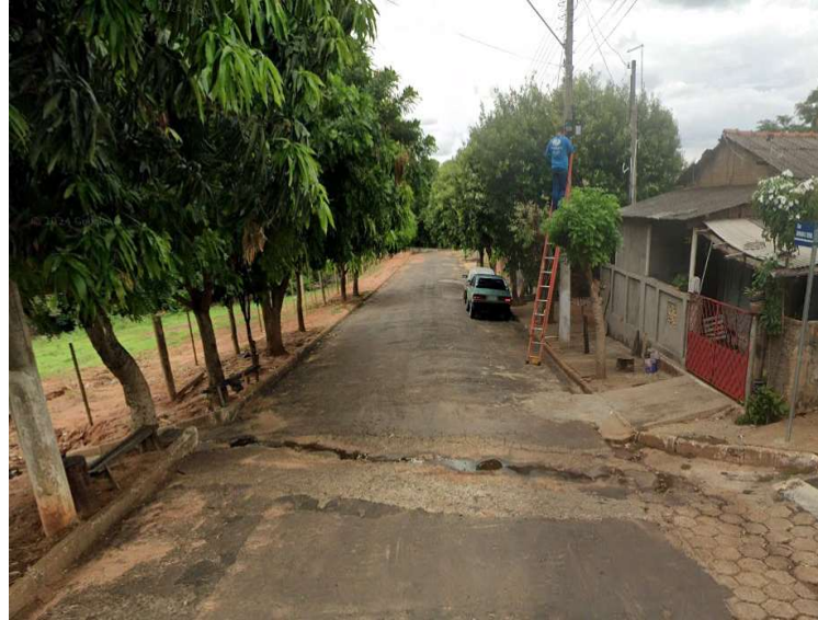
Figura 02 – Rua Mirian Vieira Nardi – ponto mais baixo da bacia de contribuição 04 – onde há ocorrências de alagamentos.
